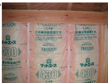
（参考写真：壁の断熱材施工の様子）
