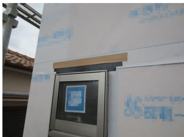
（参考写真：開口部周りを防水テープにより補強している）
