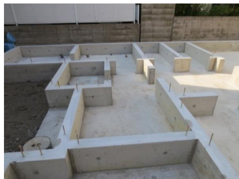
綺麗に完成した基礎の様子
