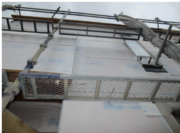
（参考写真：防水紙が下から上に重ね合わされている）
